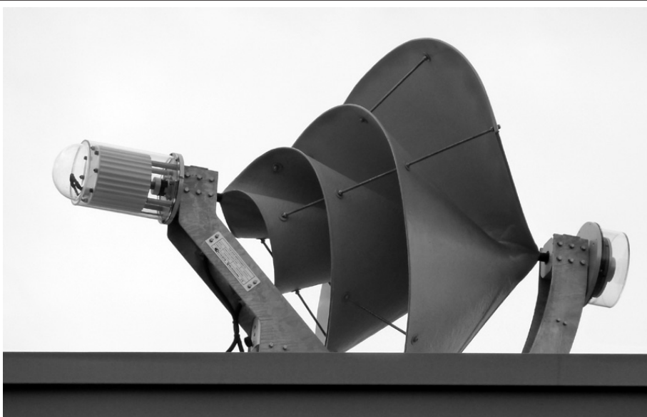
Wokkel op het dak bij Van der Graaf Installatietechniek
